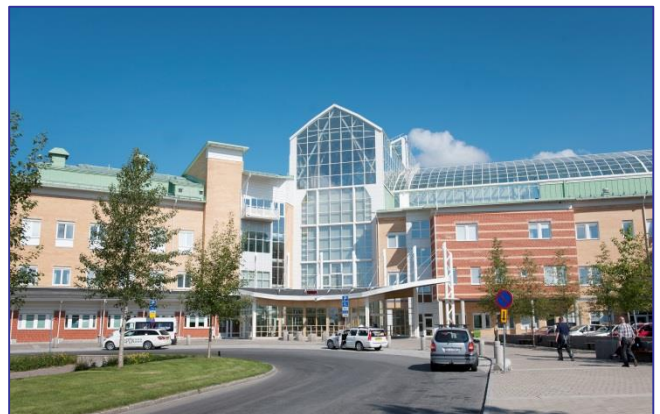
Vårt flaggskepp Sunderby sjukhus som ännu står stadigt i leran utanför Luleå.
